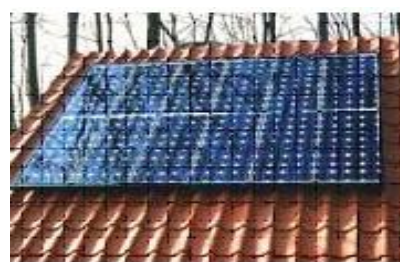
Posés sur la toiture
