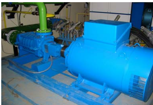
Photo 1 pompe d'enneigement (moteur + pompe)
